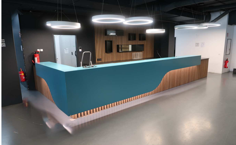
REZEPTION & SERVER RAUM
